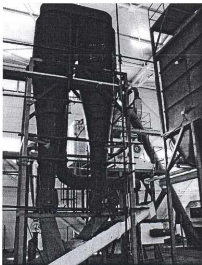
Slika 2. Detalj ugradnje ciklona d = 1.245 \text{ mm}
